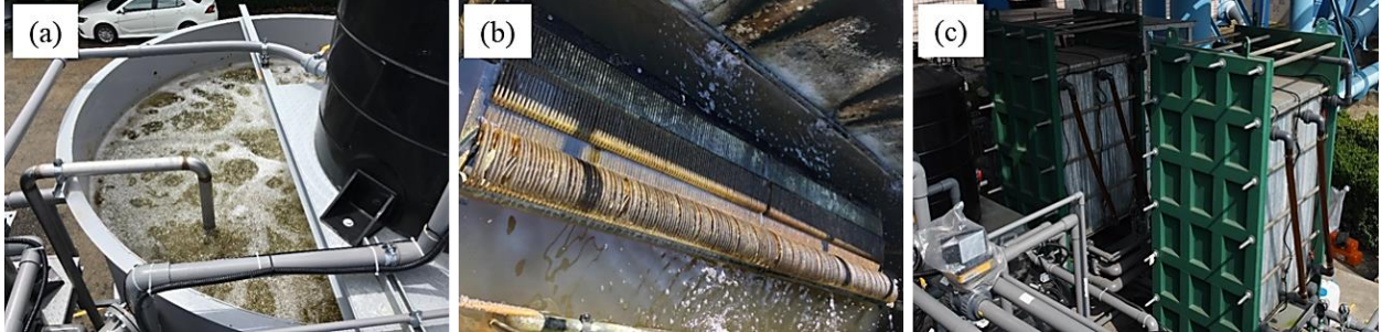
圖 3.13 林園污水處理廠水回收系統模廠：(a) BioNET 單元；(b) UF 單元；(c) EDR 單元
