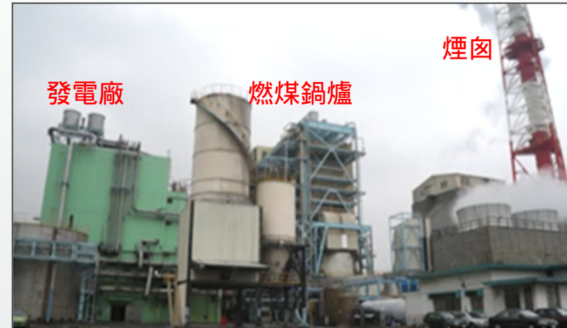
苗栗C化工廠-59MW汽電共生系統
