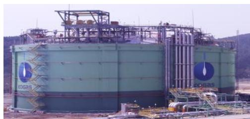
建造及操作 LNG儲槽及天然氣管線
