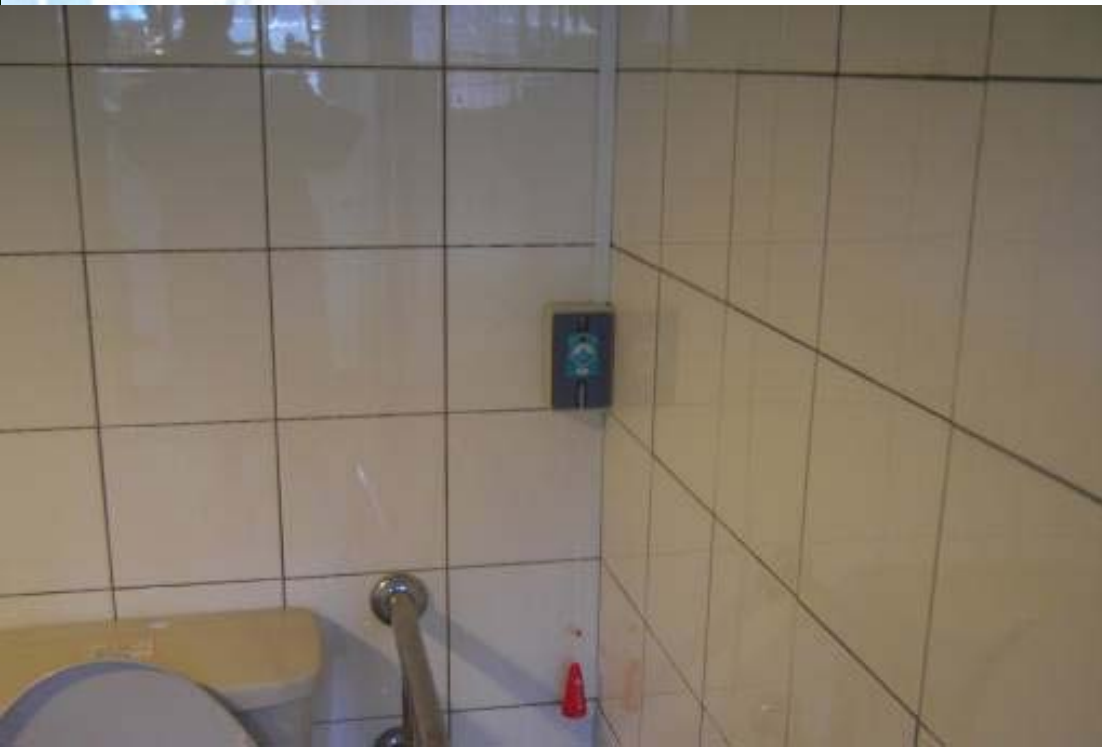
廁所緊急押扣施工
