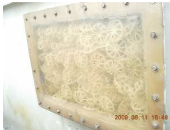
填充層裝填完成，蓋板復原
