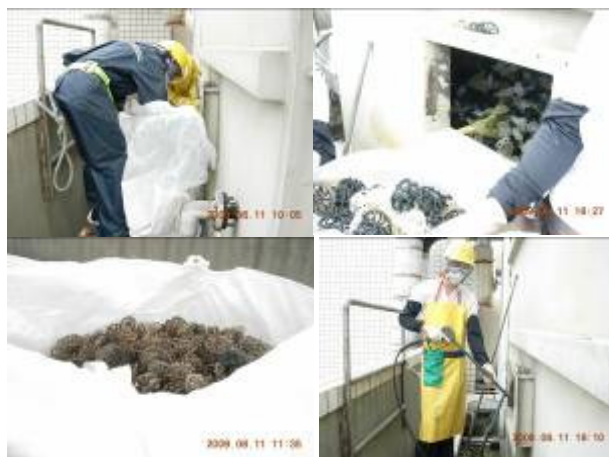
拆卸填充材及高壓水柱清洗桶體
