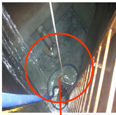
清洗後槽壁無附著底部無淤泥
