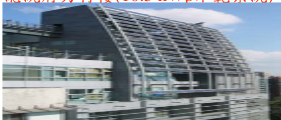
福安紀念館(19.8 kWp示範系統)
