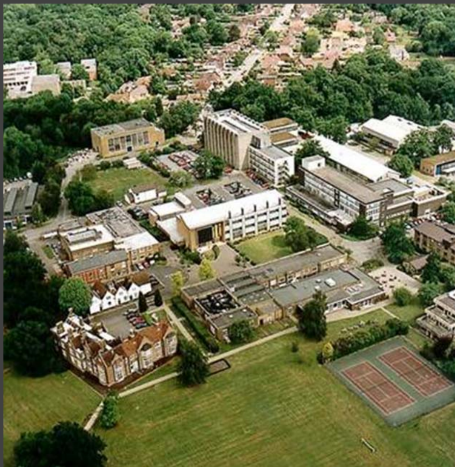
BRE main site in Watford, England 主要场所位于英格兰沃尔福德
