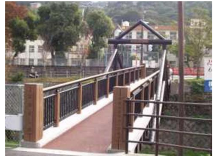
鋪設實例(八幡東區)
