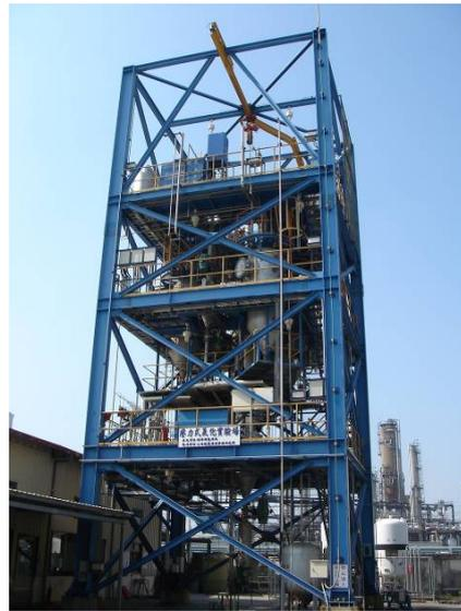
圖8、2噸煤炭/天壓力式挾帶床氣化爐
