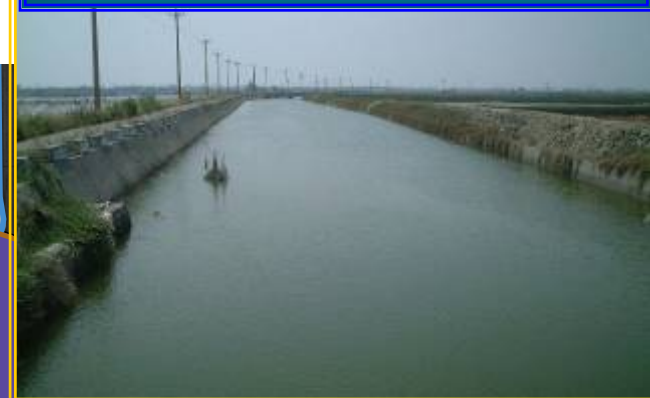
補強村落圍堤
