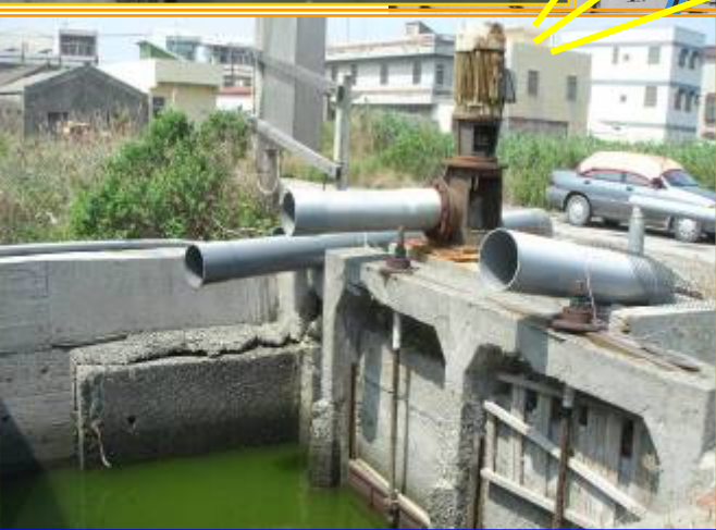
改善及新設抽水站
