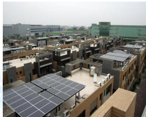
臺南人間清境陽光社區 35戶+公設, 307.256kW
